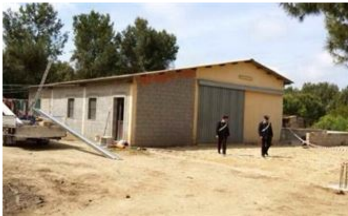
IL CAPANNONE NEL QUALE È MORTO L'OPERAIO
